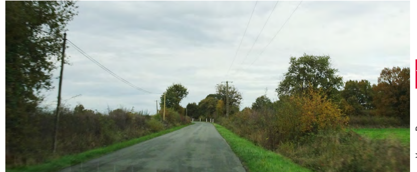
Photo 98 : À proximité de la ZIP, la RD 27 présente des vues latérales contraintes par la végétation
